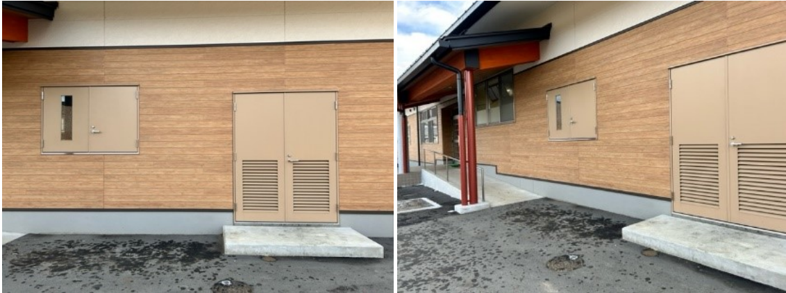
ボイラー室・サイロ室外観
