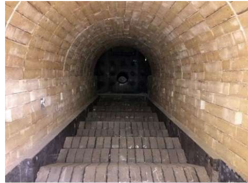
図表 6.2 階段状可動火格子
