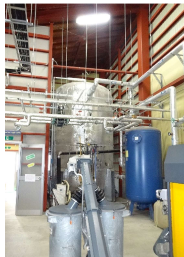
図表 6.10 10\text{m}^3 の蓄熱ボイラ
