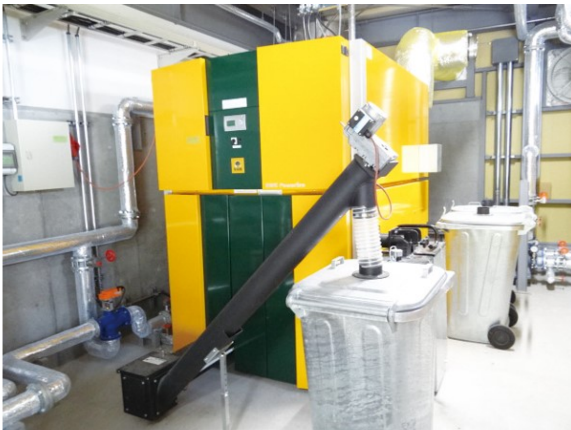
（出典：もりもりバイオマス株式会社ホームページ） チップボイラー
