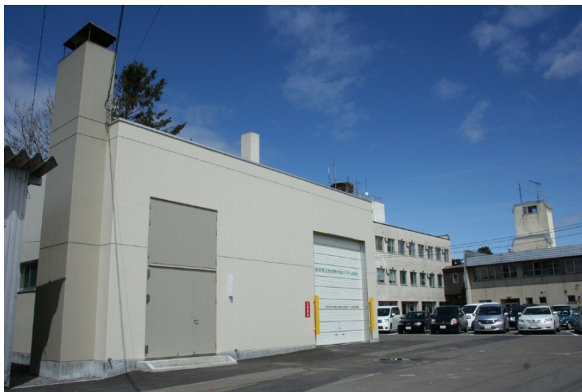
燃供給施設外観
