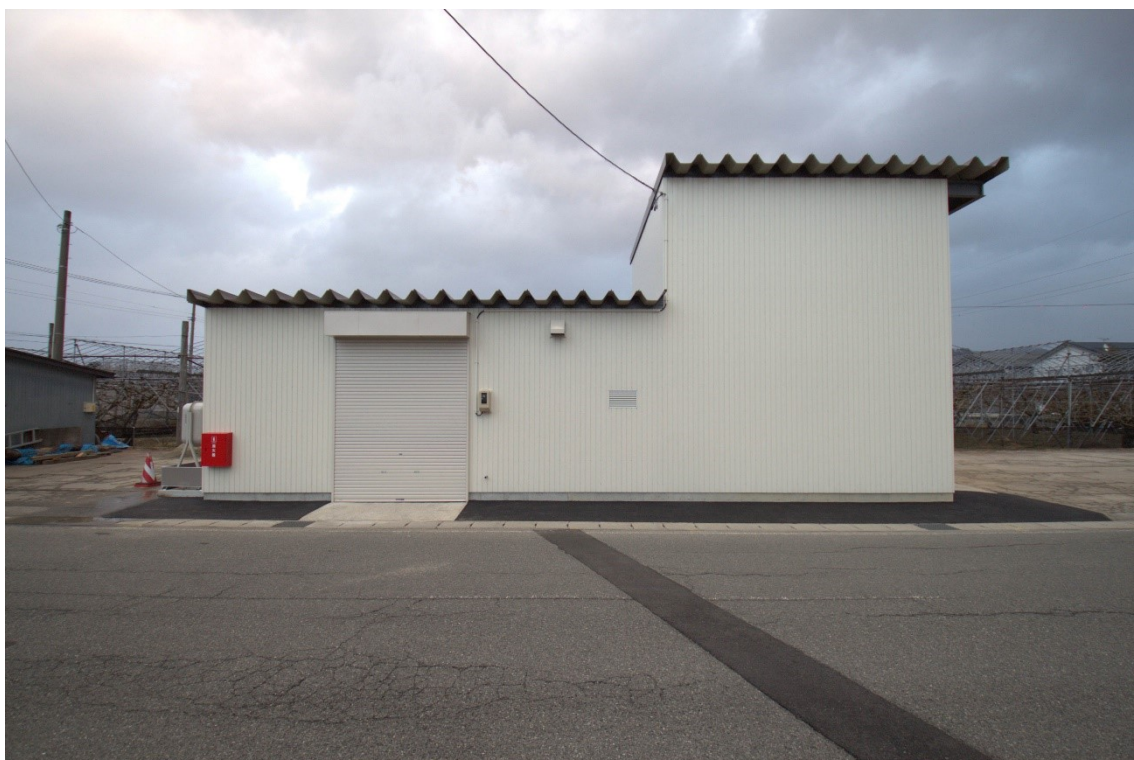
ボイラー施設外観
