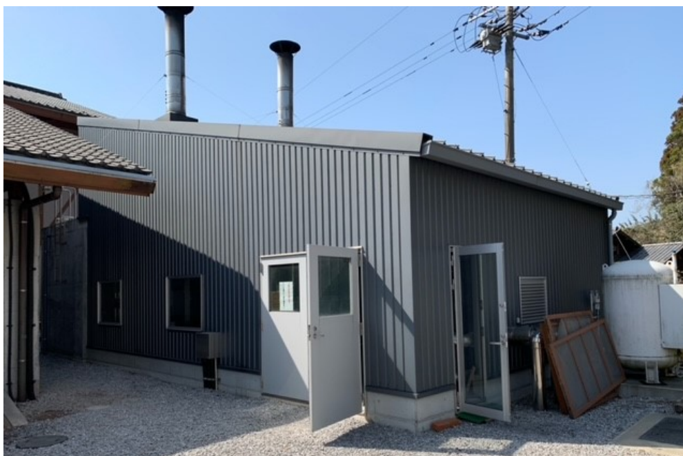
ボイラー室外観
