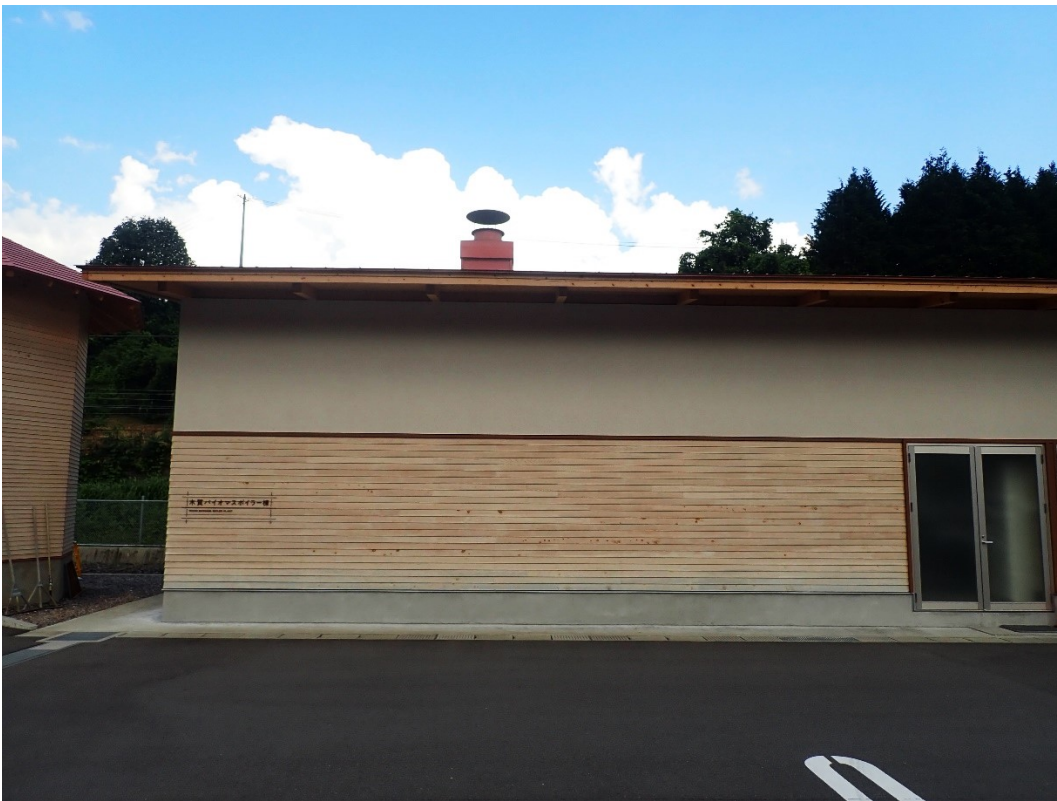
木質バイオマスボイラー棟
