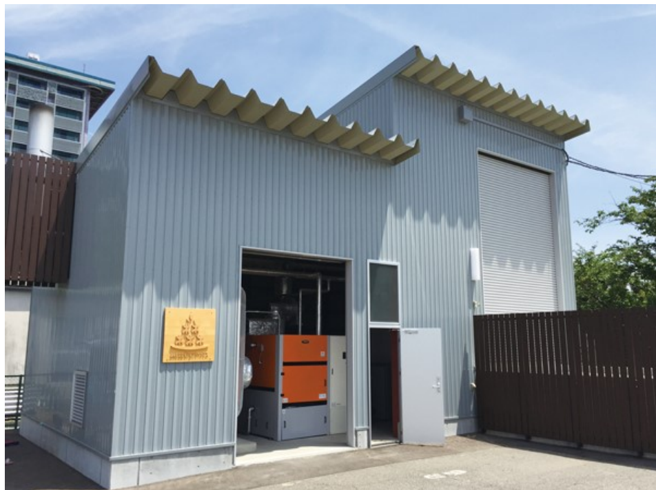
(出典：もりもりバイオマス株式会社ホームページ) ボイラー室 (1号機)
