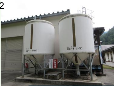
熱電併給施設（サイロ、ガス化炉）
