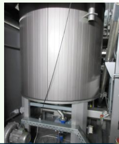
熱電併給施設（サイロ、ガス化炉）
